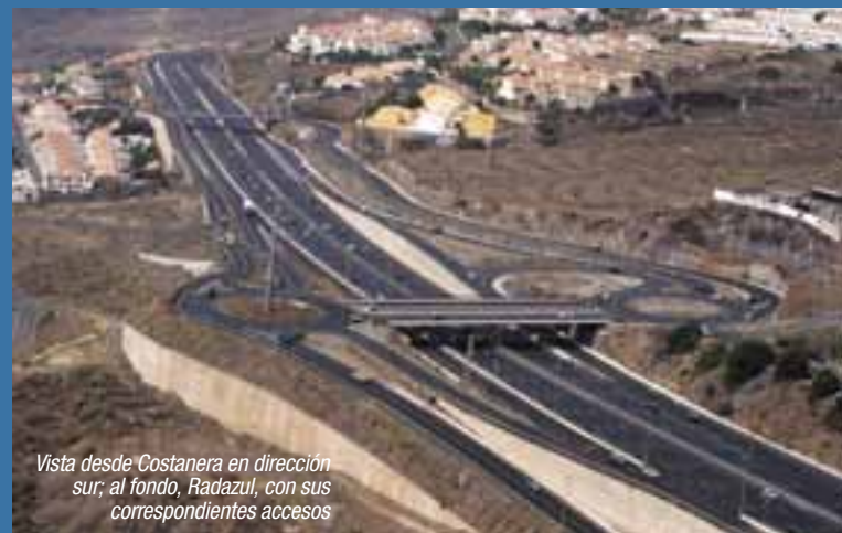
El muro de Las Caletillas fue una de las actuaciones de mayor complejidad en la obra de la TF-1
