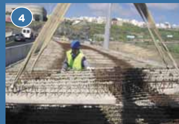
4 Colocación de las prelas, también prefabricadas
