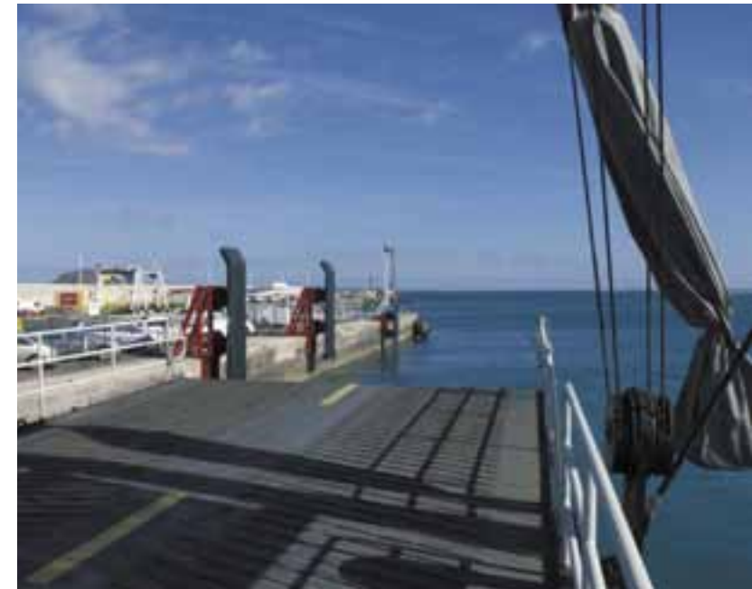
En ambos puertos se construirá un dique exterior, una nueva dársena, pantalanes y atraques para embarcaciones de recreo
