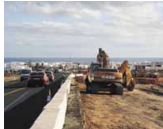
Maquinaria durante los trabajos de movimiento de tierra en la LZ-1
