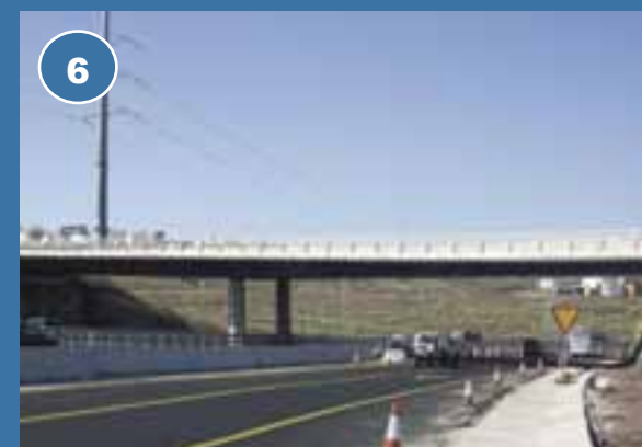
6 El puente, una vez concluidos todos los trabajos
