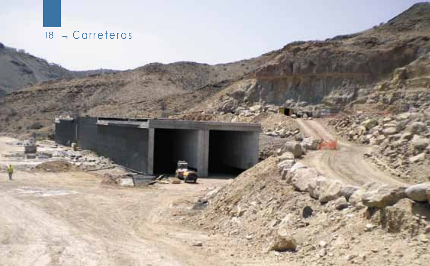
La Consejería trabaja intensamente en la construcción de los túneles de la autopista Puerto Rico-Mogán
