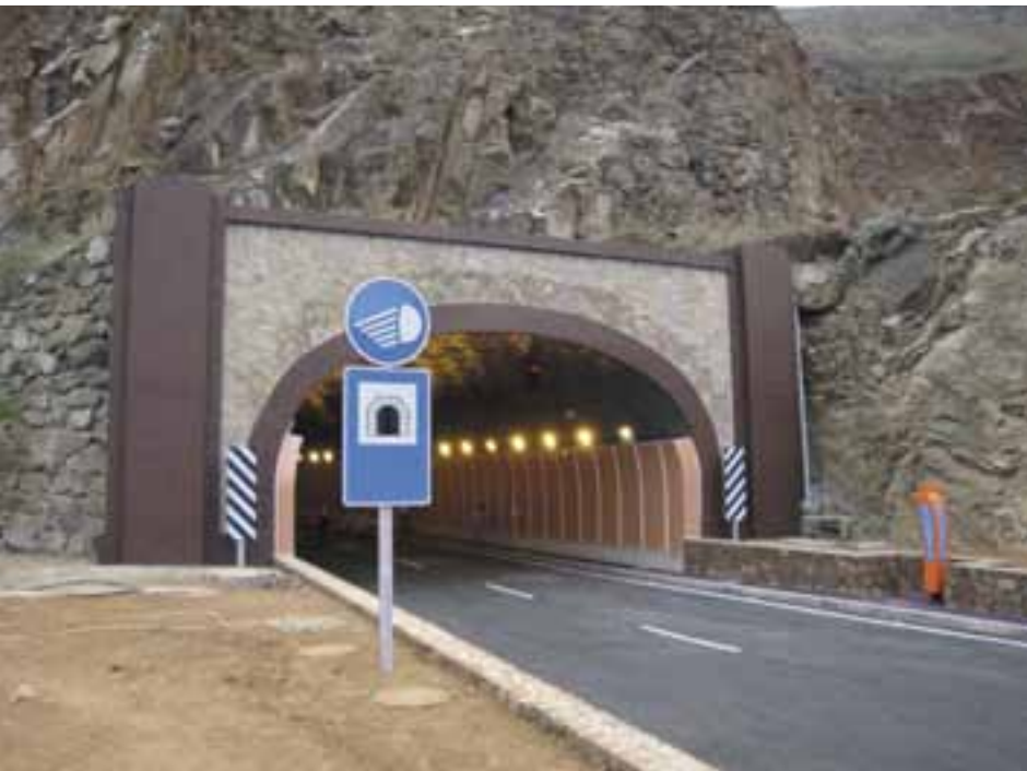
El túnel de La Portada, mientras se realizaban los últimos remates de la obra
