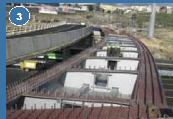
3 El puente completo, con la parte metálica ya soldada
