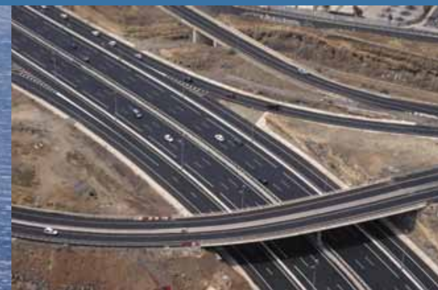
Enlace de Barranco Hondo, en el primer tramo mejorado de la TF-1, con el puerto deportivo de Radazul al fondo
