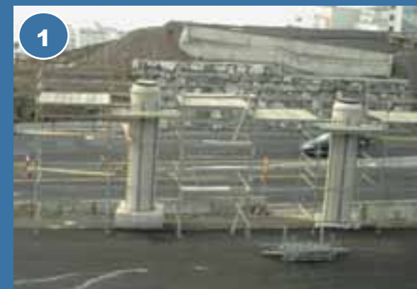
1 Pilas del puente y, al fondo, el estribo de la infraestructura
