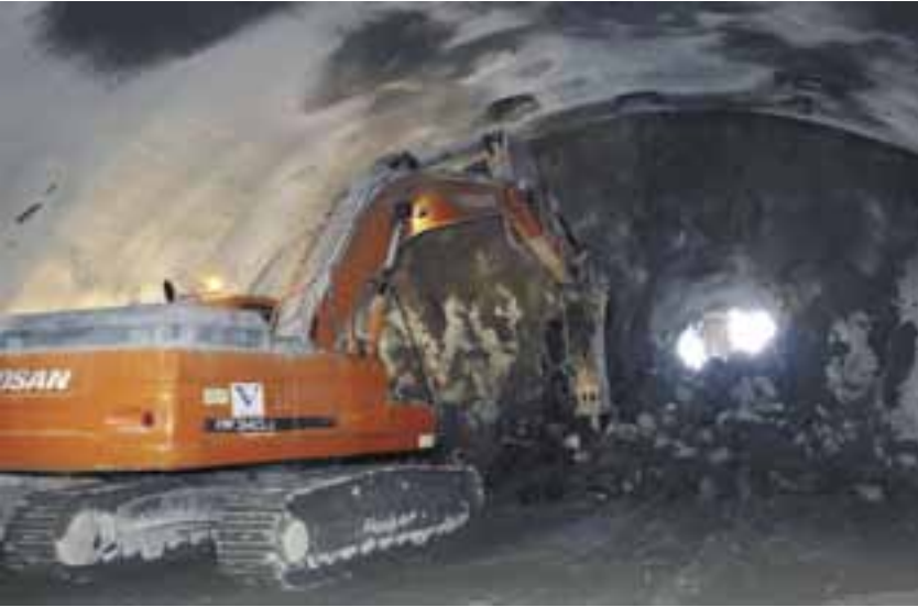
Instante en que se encuentran las dos bocas del túnel de La Vega
