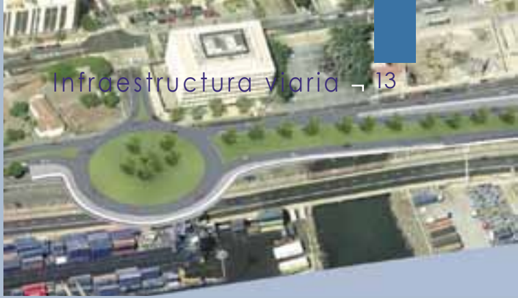
Antes y después de la zona donde comienza el tramo en el que se va a actuar
