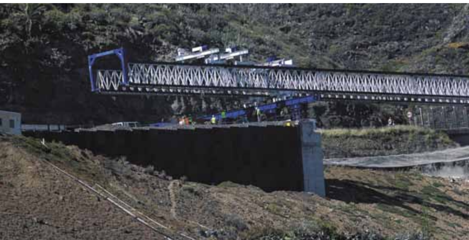
Las vigas que formarán los tableros del viaducto miden entre 40 y 43 metros de largo y pesan 80 toneladas
