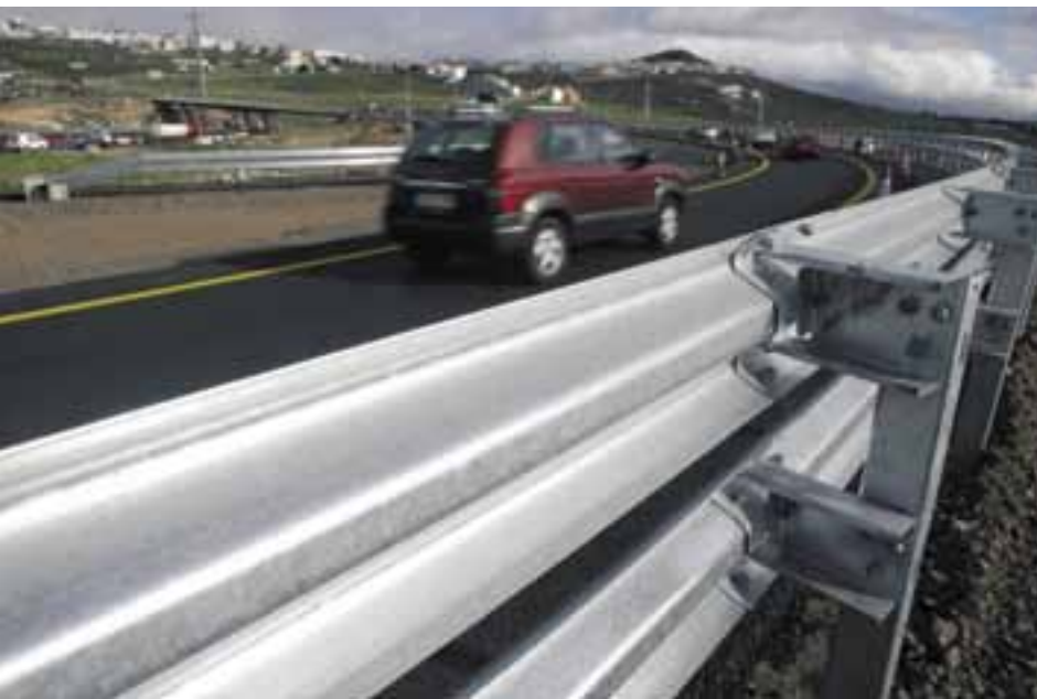
Vallas colocadas en la TF-1 durante las obras de ampliación
