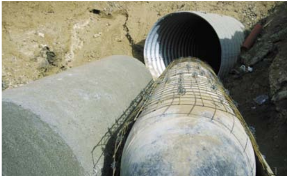
Los trabajos permitirán dotar a Arrecife de un sistema adecuado de evacuación de las aguas de lluvia
