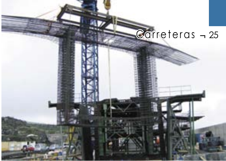
Obra de la TF-1, en la que se utilizan grandes máquinas
